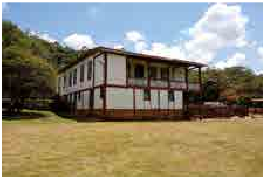
Figura 1 – Casa sede da Fazenda do Gualaxo, alvo de intervenção de conservação e restauro após a passagem do rejeito.
