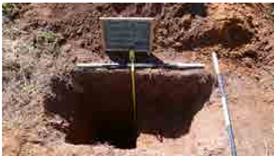
Figura 9 – Sondagem 8 finalizada, onde se nota a cama de rejeito acumulada na área, da intervenção.
