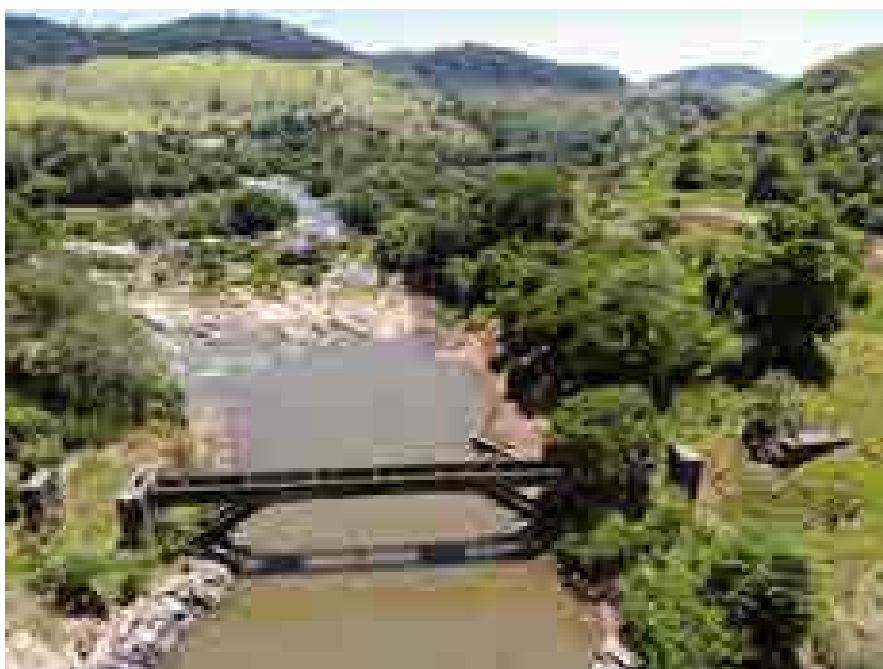
Figura 14 – Registro dom bem com apoio de VANT, onde se avista em segundo plano o Encontro das águas dos rios do Carmo e Piranga.
