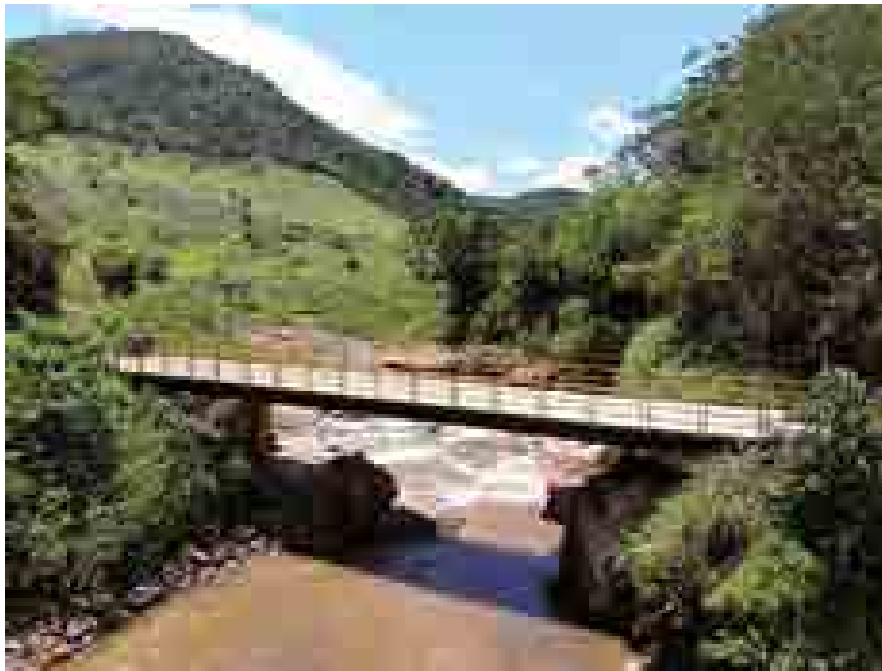
Figura 7 – Nota-se abaixo da ponte, na margem esquerda, ruínas da antiga estrutura.
