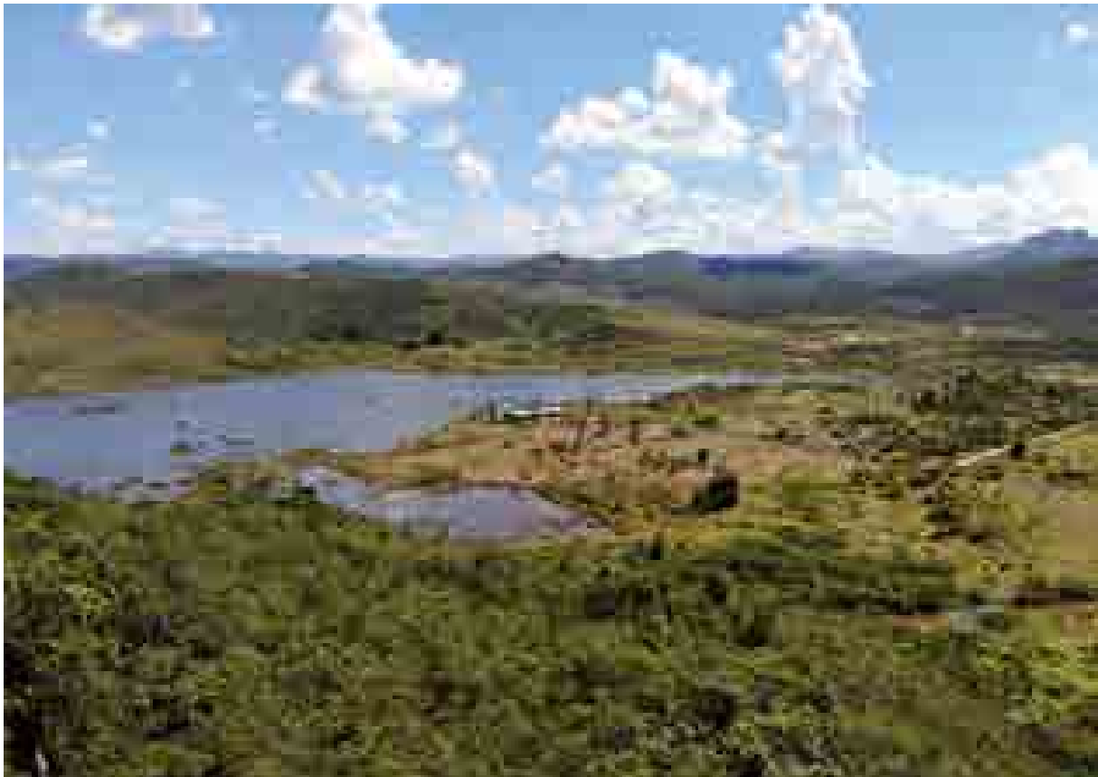
Figura 15 – Vista aérea de Bento Rodrigues, em direção à área amplamente atingida pela torrente de rejeito. Com a implantação do Dique S4 pela Samarco, parte considerável do povoado foi submerso.
