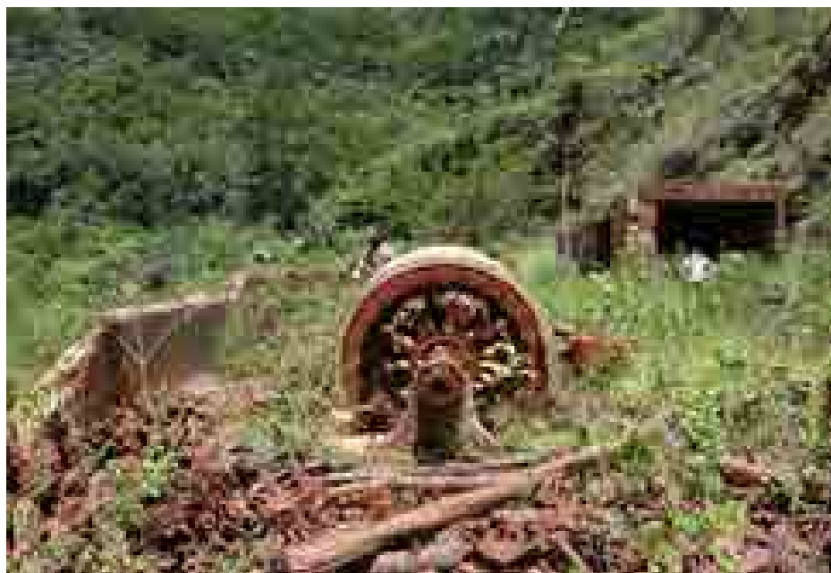
Figura 15 – Turbina atingida pela onda de rejeitos.
