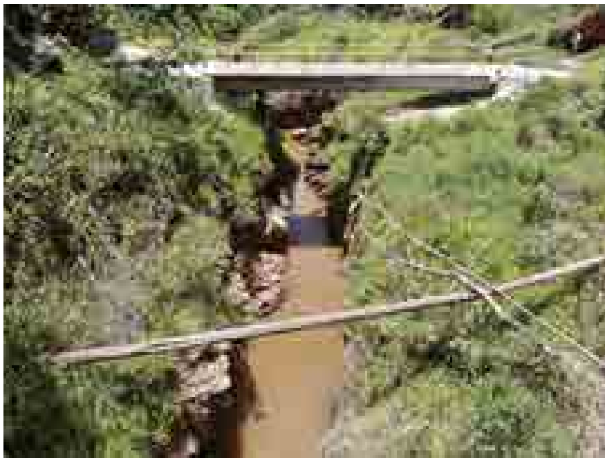
Figura 14 – Vista da área de extração mineral e ponte atual justaposta à estrutura mais antiga.
