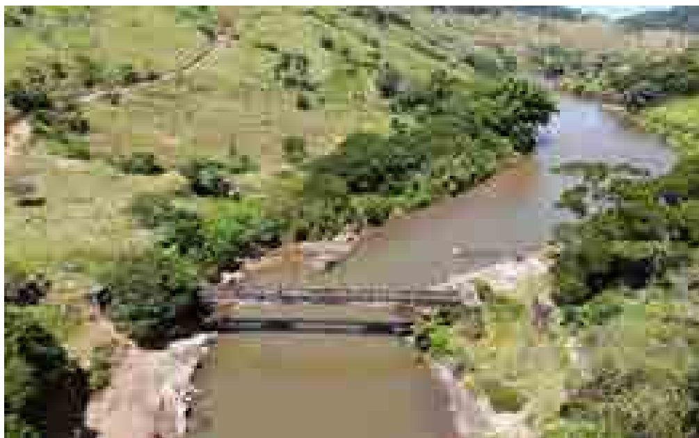
Figura 2 – Vista da Ponte com uso do VANT.
