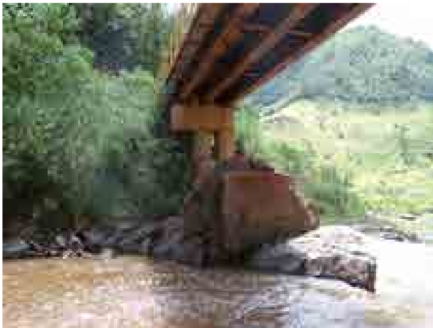
Figura 15 – Pilares da ponte atual, construída sobre as ruínas da antiga estrutura.
