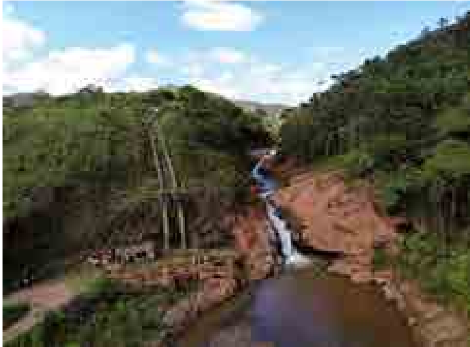
Figura 5 – Vista da área dos dutos até a área de equipamentos de geração de energia.
