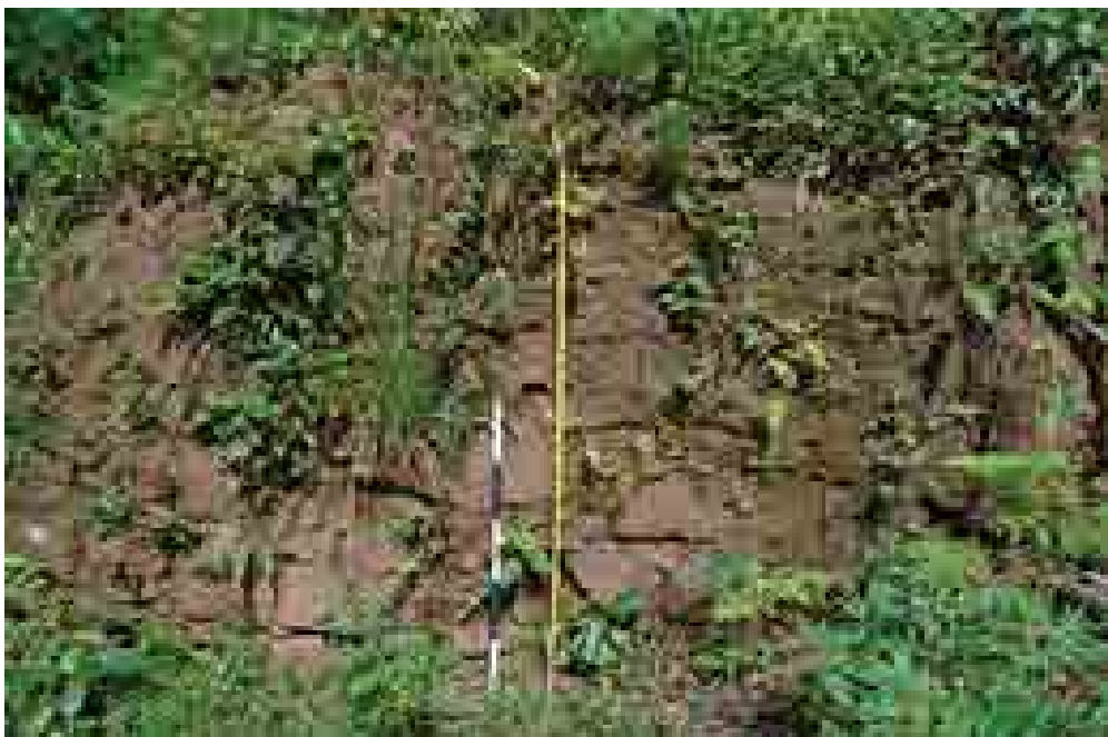
Figura 21 – Registro das dimensões da estrutura 2, correspondendo a muro de pedras impregnado com rejeito.
