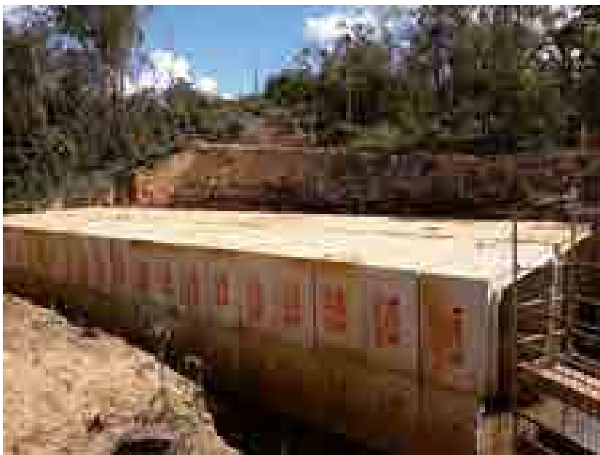
Figura 9 – Estrutura de concreto utilizada para canalização do córrego, relacionada ao reassentamento da Nova Bento Rodrigues.
