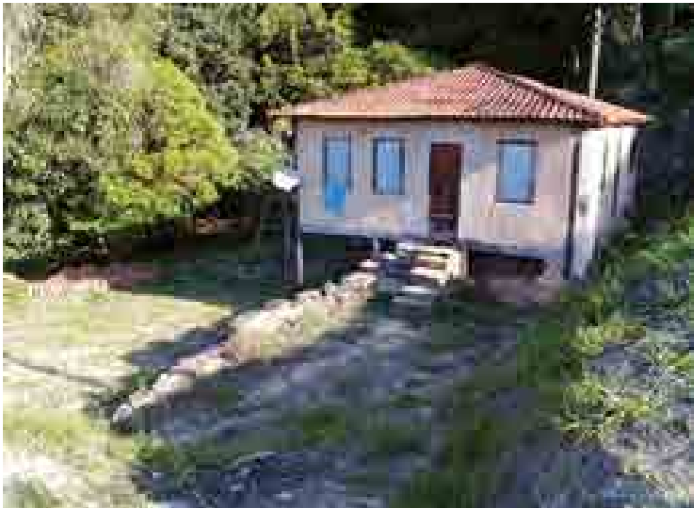
Figura 2 – Edificação antiga remanescente, situada próxima ao centro de Paracatu de Baixo, em cota mais elevada: as porções mais altas do povoado escaparam da torrente de lama/rejeito e continuam habitadas
