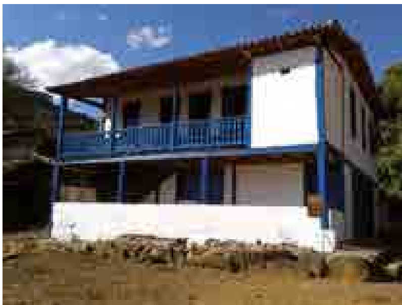
Figura 1 – A casa sede da fazenda, bem cultural acautelado pelo município de Barra Longa.
