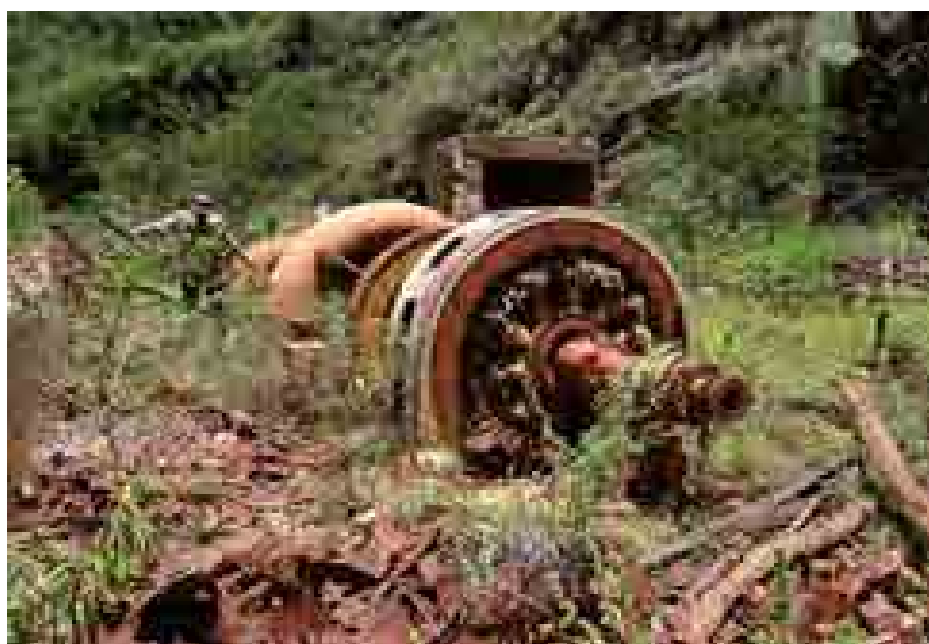
Figura 16 – Detalhe do conjunto de turbinas para geração de energia.
