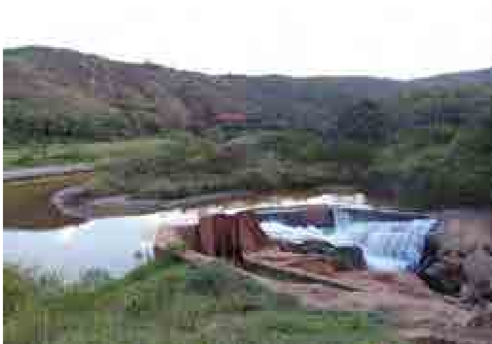
Figura 1 – Área da barragem e represamento do rio Gualaxo do Norte, na porção sul da área estimada do SIAHA.
