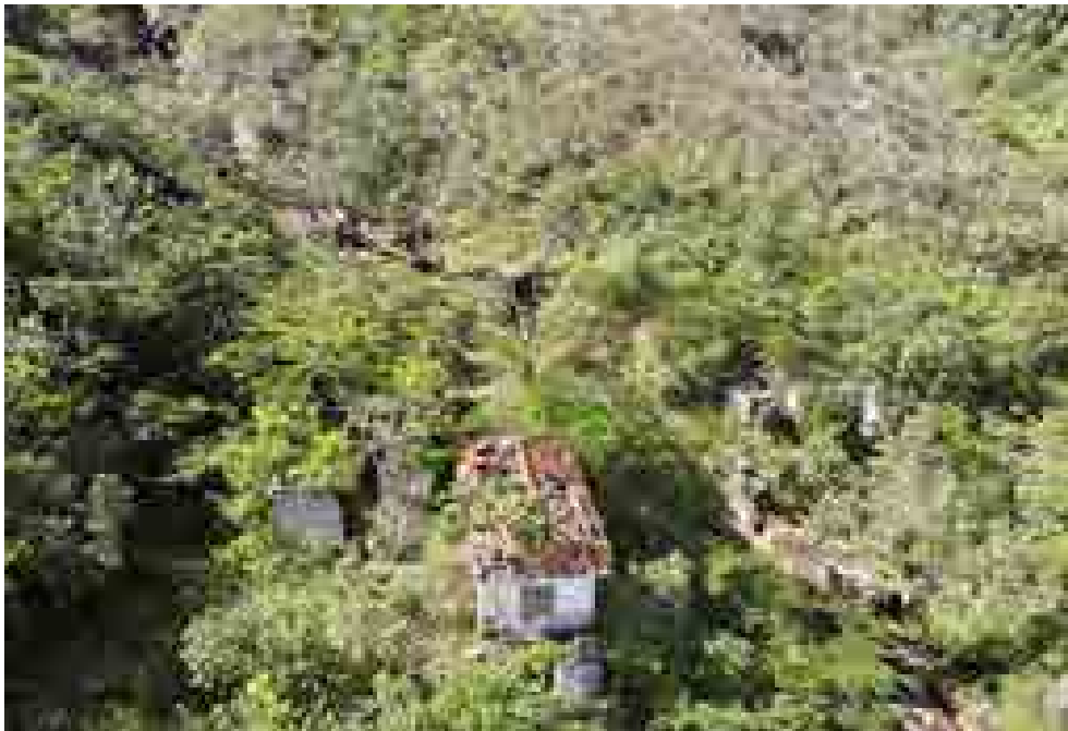
Figura 2 – Ruínas de edificações tomadas pela vegetação (margem direita do córrego).
