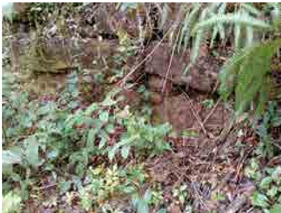
Figura 2 – Detalhe do patamar inferior de estrutura de pedras em cota positiva.
