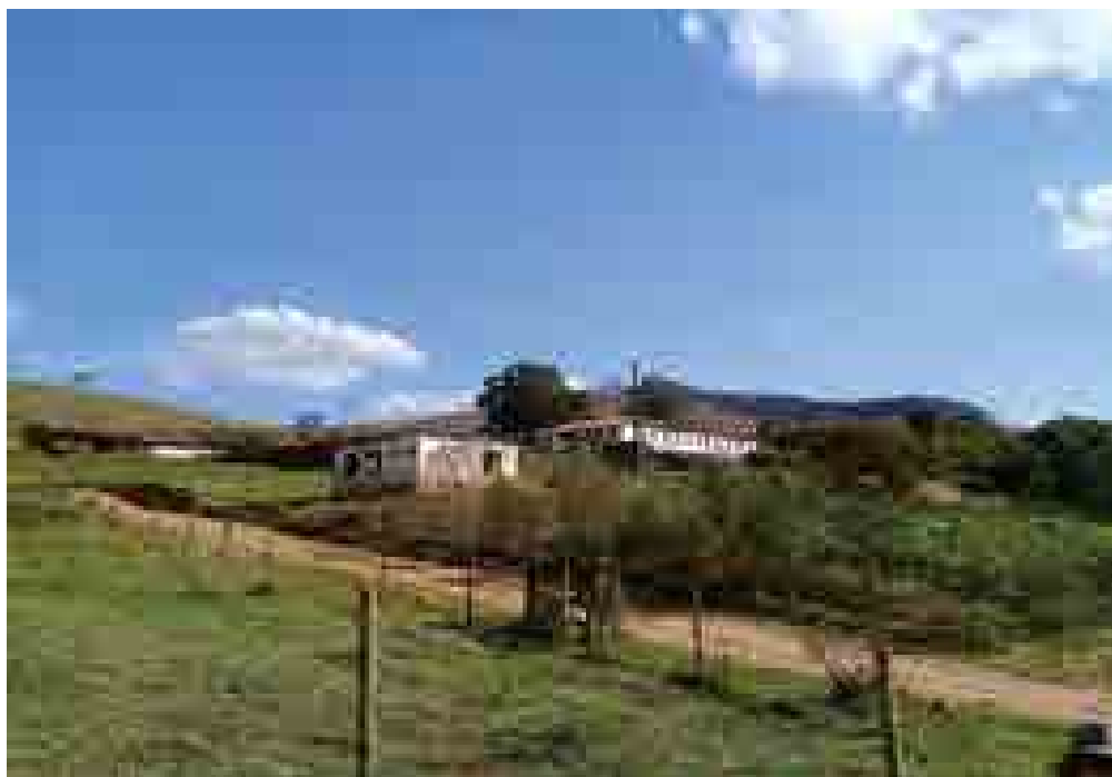
Figura 1 – Perspectiva do conjunto arquitetônico da Fazenda Corvinas, bem tombado pelo município no ano de 2005.
