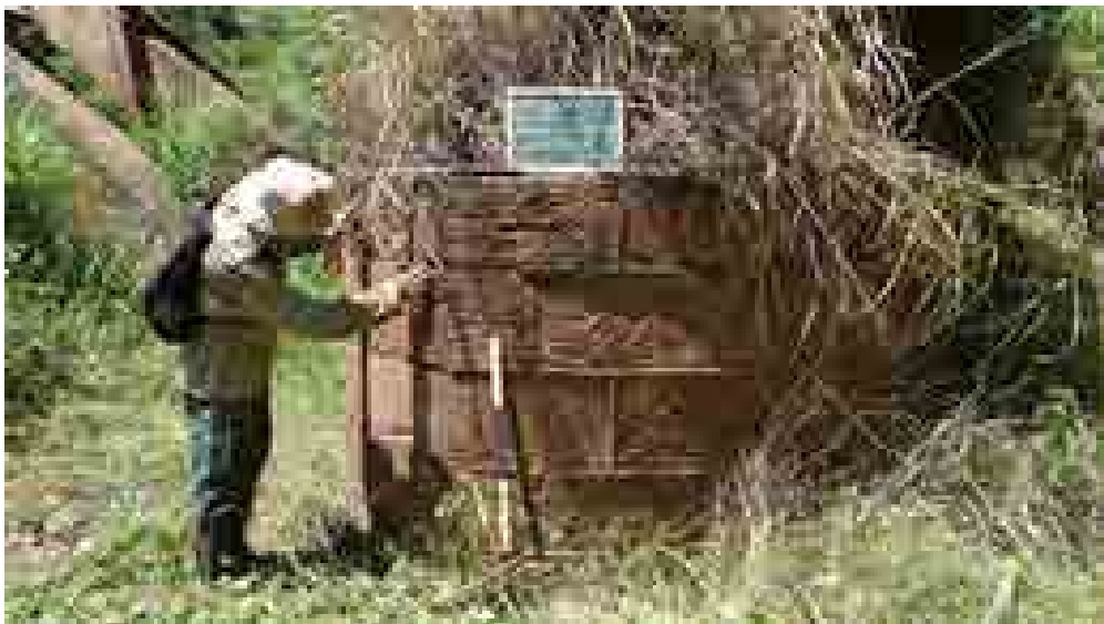
Figura 6 – Pilares associadas à implantação da estrutura original da ponte no final do século XIX. Nota-se a impregnação do rejeito à superfície da estrutura.
