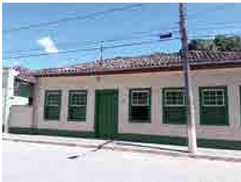
Figura 12 – Casa localizada na Rua Matias Barbosa, 413, de propriedade de 11381, onde foi executada a Sondagem 1.
