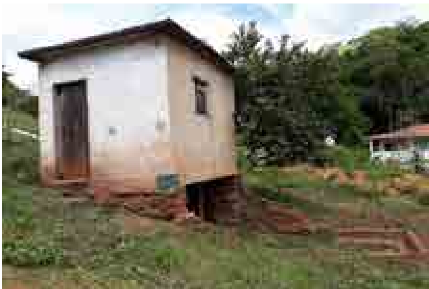
Figura 4 – Moinho que teve seu sistema atingido pela passagem de lama, exibindo as marcas de rejeito: nota-se a estrutura edificada de alvenaria assentada sobre embasamento de pedras mais antigo.
