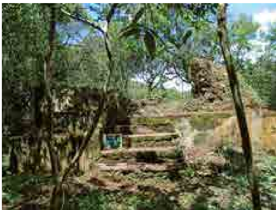
Figura 8 – Detalhe de escada lateral que dá acesso ao provável espaço da cozinha.
