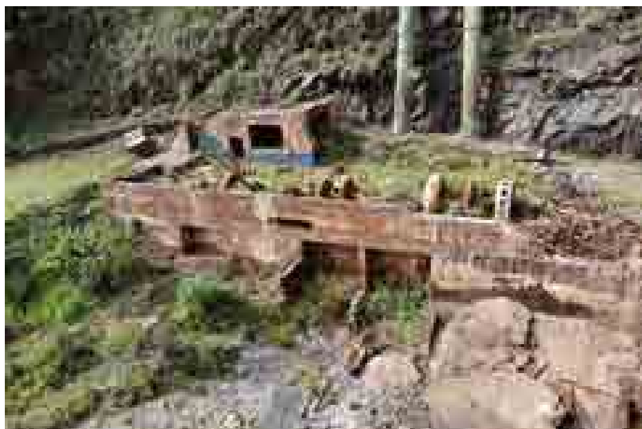
Figura 14 – Vista das ruínas da PCH Bicas com o apoio de VANT.
