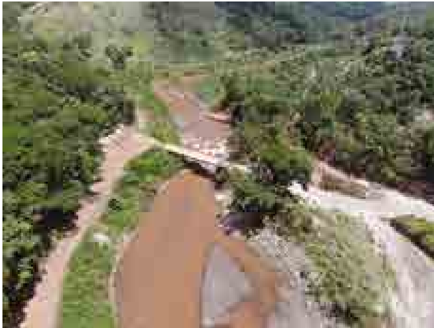
Figura 5 – Atual ponte, em vista no sentido a jusante do rio do Carmo utilizando VANT.
