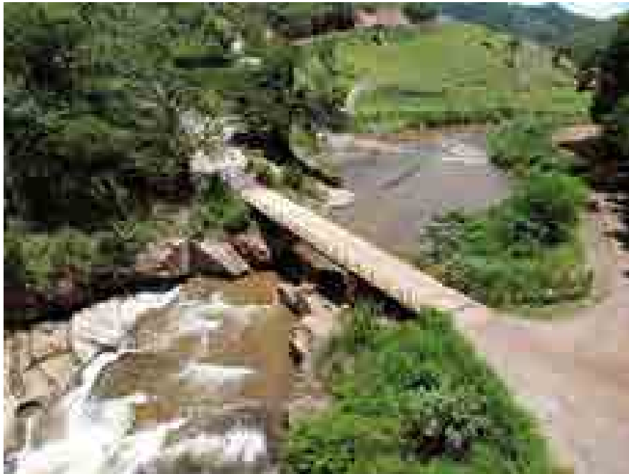
Figura 6 – Atual ponte, em foto tomada por VANT, olhando à montante.
