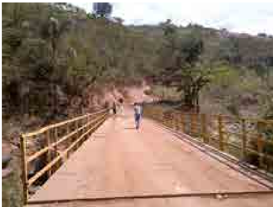
Figura 2 – Vista da ponte atual.
