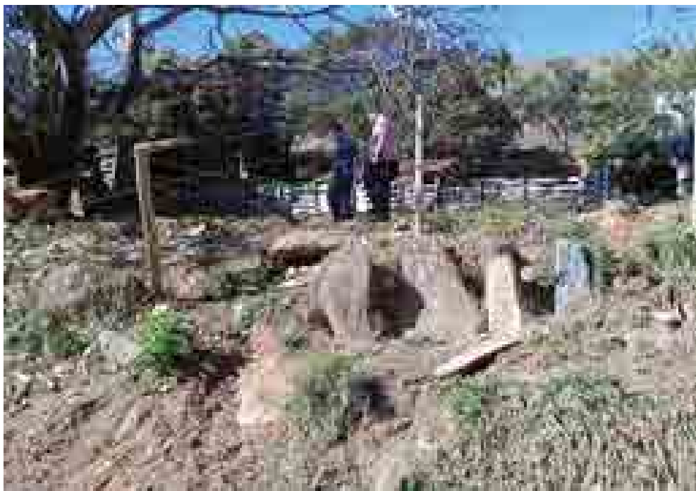
Figura 2 – Lajes de pedra aplicadas paralelamente para a contenção de parte do talude da margem do curso d'água
