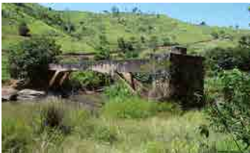
Figura 1 – Vista para a ponte.
