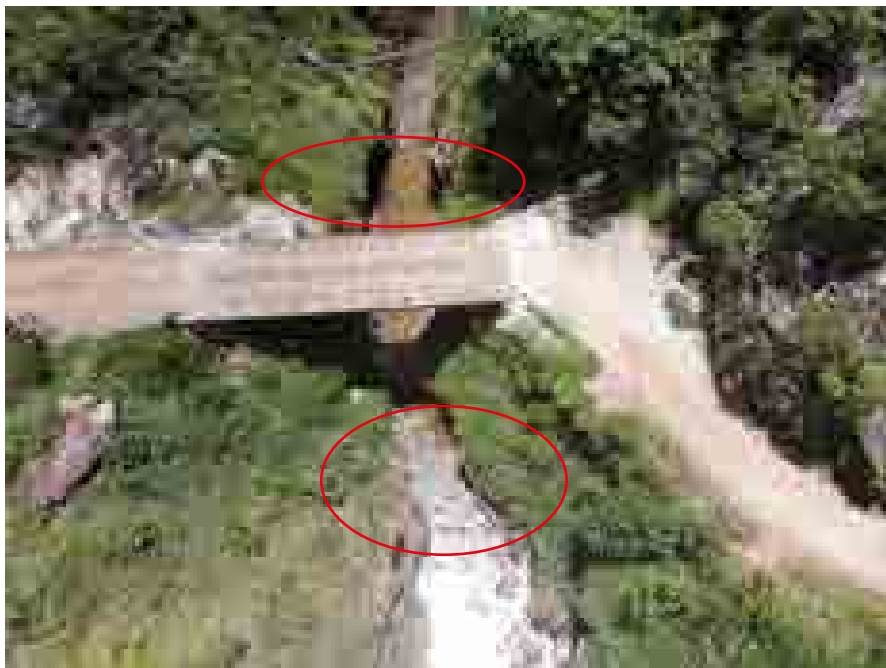
Figura 18 – Vista da ponte atual evidenciando as interferências produzidas pelas obras emergenciais. A passagem do rejeito provocou o arraste e supressão do solo e vegetação superficial, expondo repentinamente marcas de natureza antrópica ali presentes. Os entalhes demarcados na porção inferior da foto são certamente relativos a encaixes para antiga ponte de madeira.
