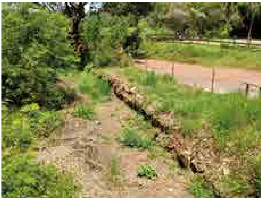
Figura 12 – Rejeito sobre estrutura linear de pedra coalinhada à via.
