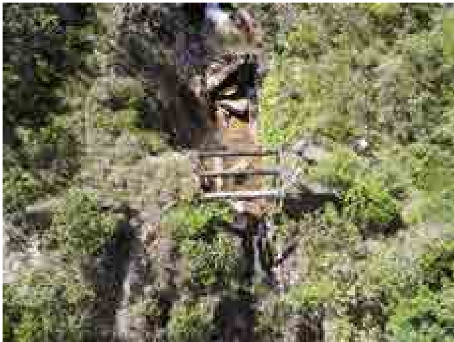
Figura 6 – Vista aérea de parte da via e estrutura de ponte erguida para transposição do córrego Ouro Fino.
