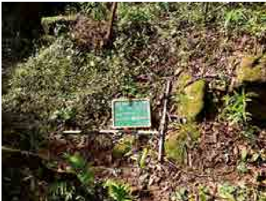
Figura 6 – Detalhe de estrutura de alvenaria de pedra recoberta por solo/rejeito.
