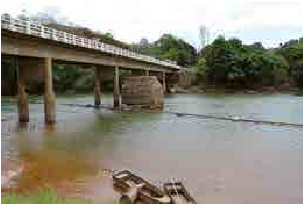
Figura 1 – Visão das estruturas da antiga ponte férrea, desde a margem do rio Santo Antônio.
